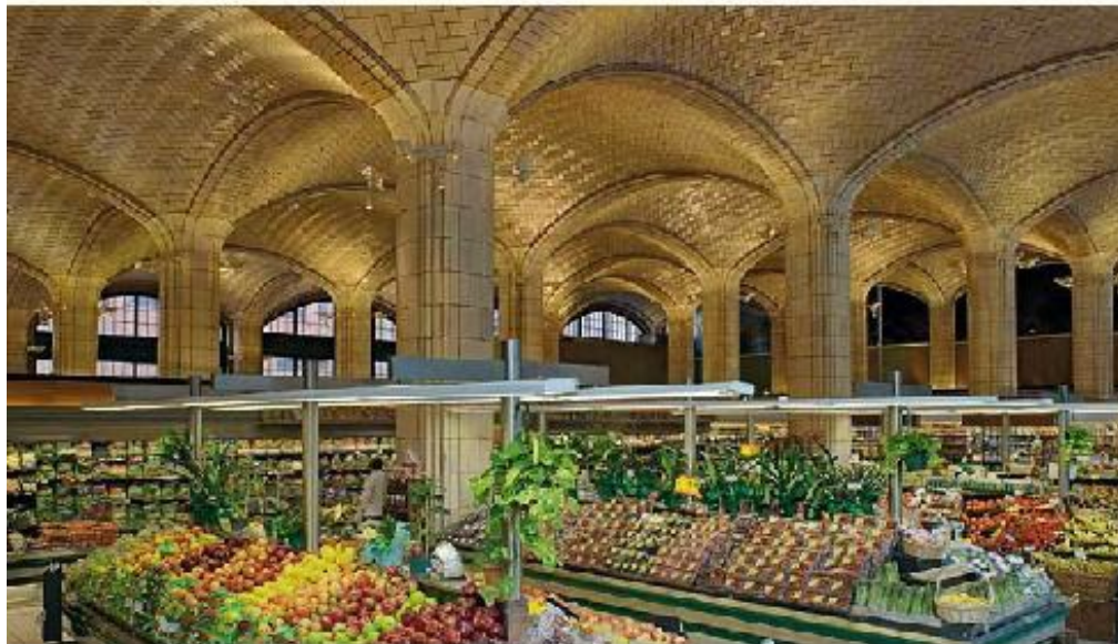
Construyeron las arcadas del puente de Queensboro, recubiertas de azulejo color crema, que servirían para cobijar un gran mercado público.
