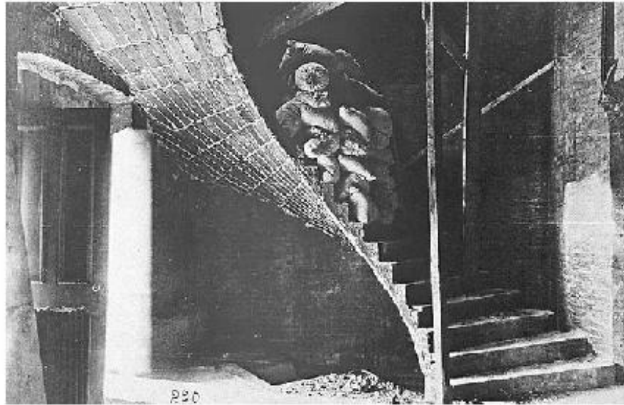
A Rafael Guastavino no le creían cuando hablaba de las propiedades de sus construcciones. ¿Cómo puede una escalera tan fina soportar tanto peso? Le pedían números, cálculos, matemáticas. Él respondía con pruebas empíricas, como esta sobre la solidez de una escalera de la iglesia de la Ciencia Cristiana en Nueva York, 1901).
