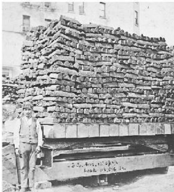
En 1901 realizaron una contundente prueba de resistencia: sobre una bóveda finísima de tres metros y medio de diámetro colocaron una carga de unas treinta toneladas que resistió perfectamente.
